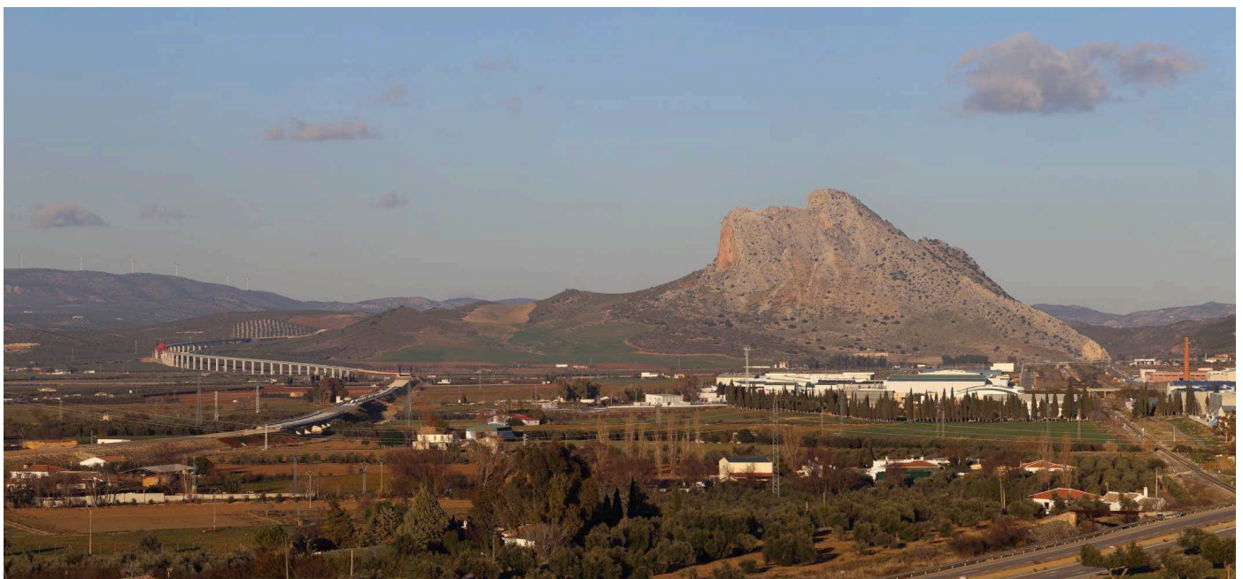
Instalaciones industriales entre Antequera y la Peña de los Enamorados
